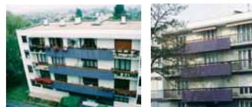
La résidence Edmond Rostand, à Boissy-Saint-Léger, avant et après travaux (remplacement des menuiseries extérieures, des vitrages et des volets roulants).
