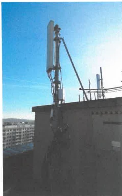
Vue de la terrasse S0 avant travaux
