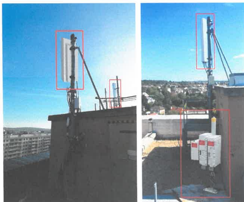
Vue de la terrasse S0 après travaux
