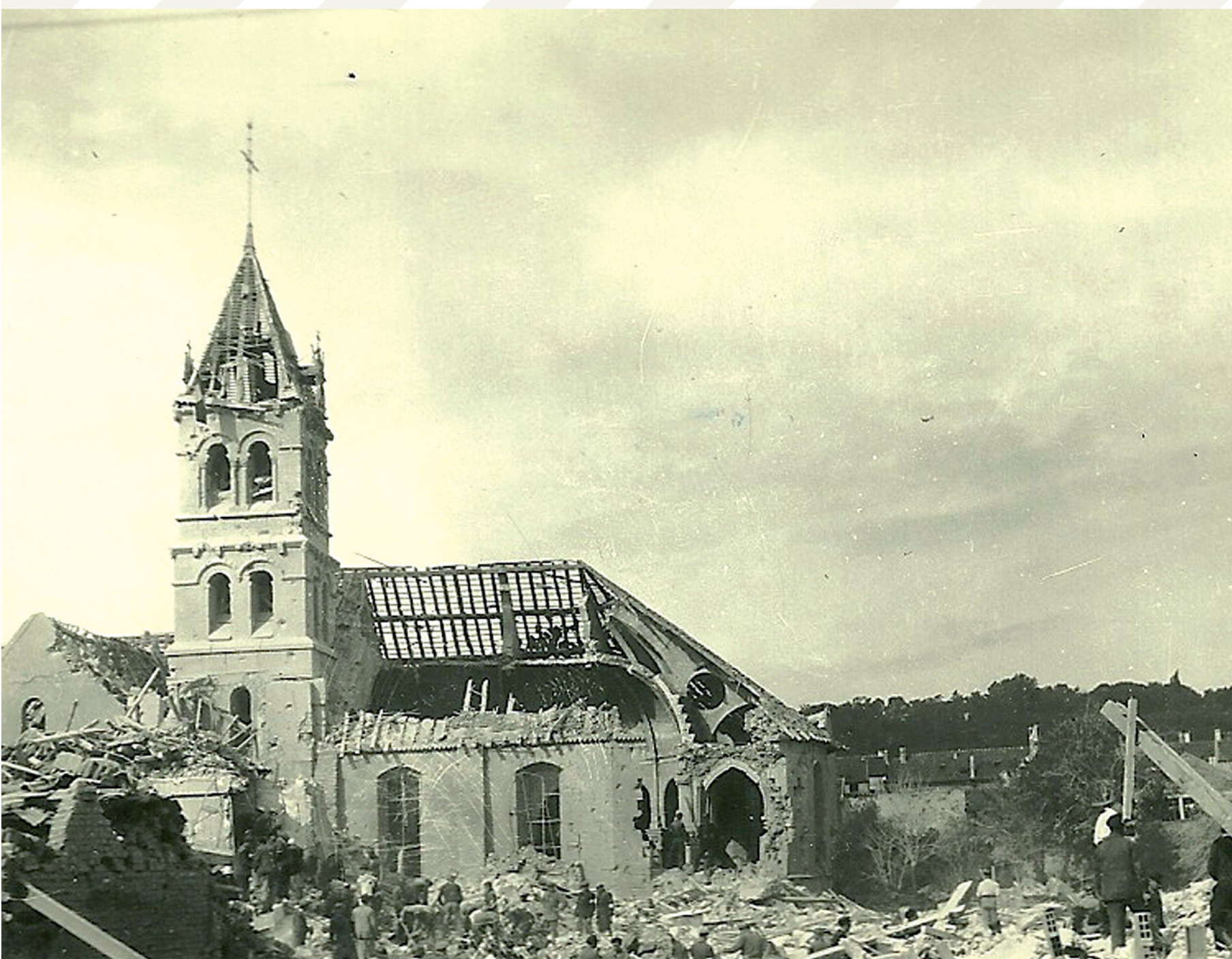
L'église après la chute du V2, les dégâts sont considérables.
