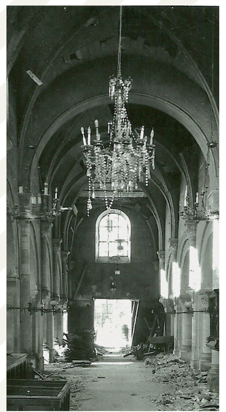
La nef jonchée de débris.
