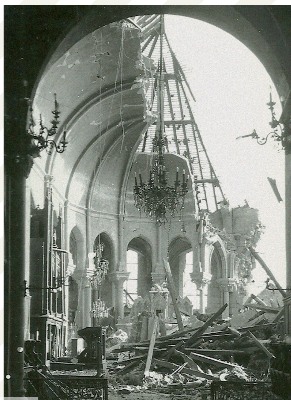
Le chœur s'ouvre sur le ciel mais une partie des colonnes est encore debout.
